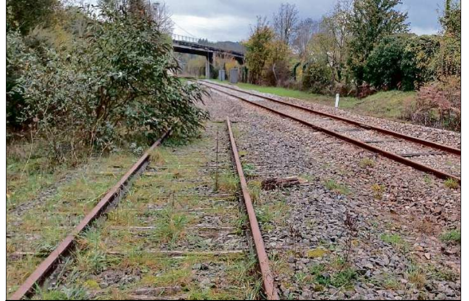
VOIE. L'aiguillage a disparu au cours de travaux d'entretien menés par SNCF réseau.
